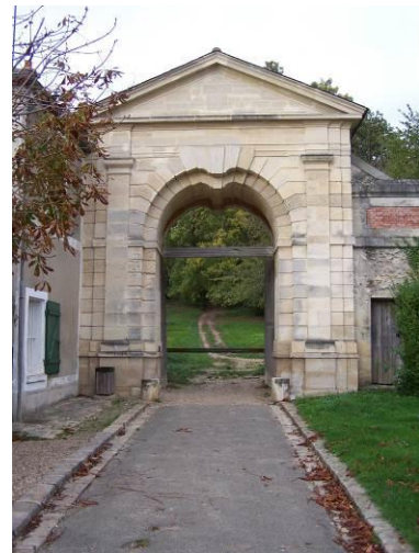
Figure 217 : Porte ancien château – Noisy-le-Roi
