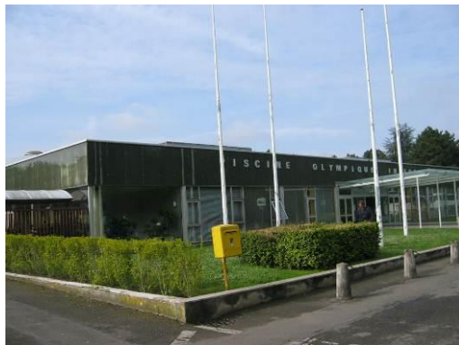
Figure 213 : Piscine olympique de Saint-Germain-en-Laye
